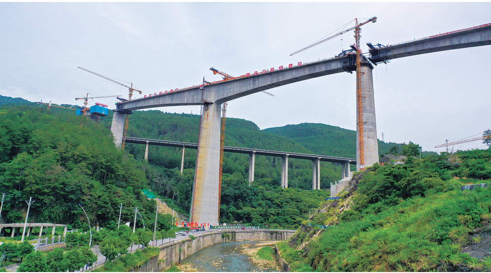
这是8月24日拍摄的石梁河双线特大桥4号墩T构桥梁合龙施工现场（无人机照片）。石梁河双线特大桥位于重庆市武隆区，是渝湘高铁重庆至黔江段控制性工程，大桥全长936.05米，从地面到桥面的高度为129.635米。
