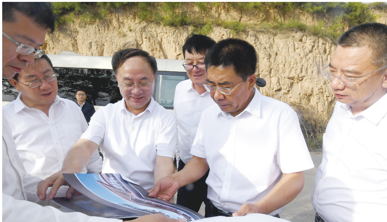
图为市委书记孙大军在孝义市老城区黑臭水体综合治理工程现场调研。 记者 王益炜 摄
