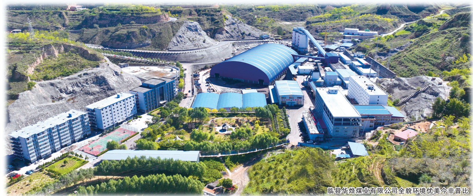
临县华烨煤业有限公司全貌环境美今非昔比
