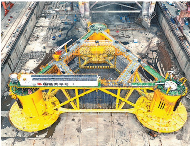
浙江舟山,正在搭建中的平台。 国家能源集团龙源电力供图
