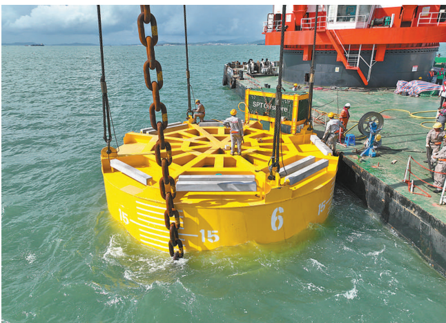
福建莆田南日岛水域,工作人员在向水下放置吸力锚筒。 林 梁摄
