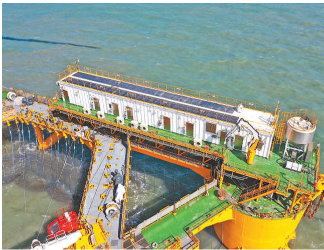
平台上的光伏电板和设备间、休息室。 陈 斌摄
