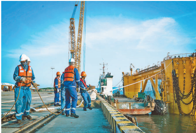
福建平潭金井码头,工作人员在对平台进行靠泊系统作业。 林启鑫 摄
