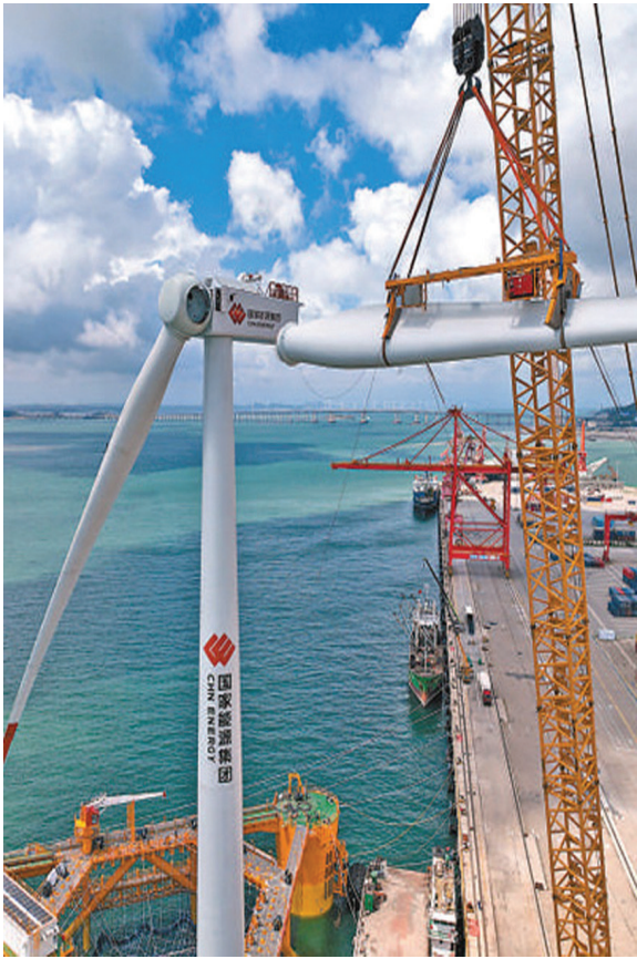
平台在进行风机第二根叶片吊装作业。 林启鑫 摄
