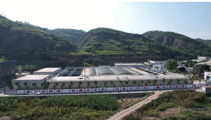
临县污水处理厂全景
