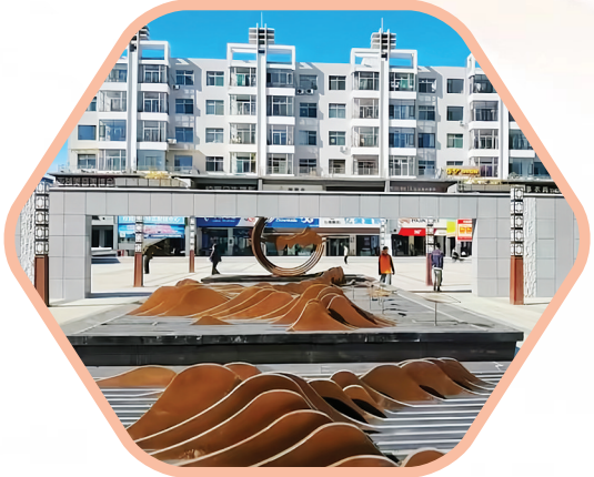
改造升级的中心广场
