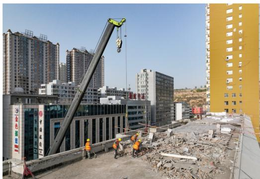
4月18日,工人对建于上世纪90年代的老旧小区进行水、电、暖、气、通信、消防等方面的综合改造。
