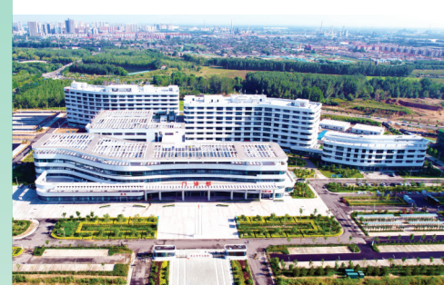
2023年12月,占地面积200亩,总建筑面积约11万平方米,设置床位800张的孝义市中心医院全面开诊。
