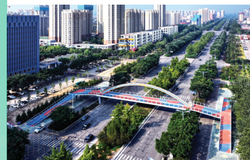
三座过街天桥陆续投入使用,校园周边的道路通行更加安全、便捷。
