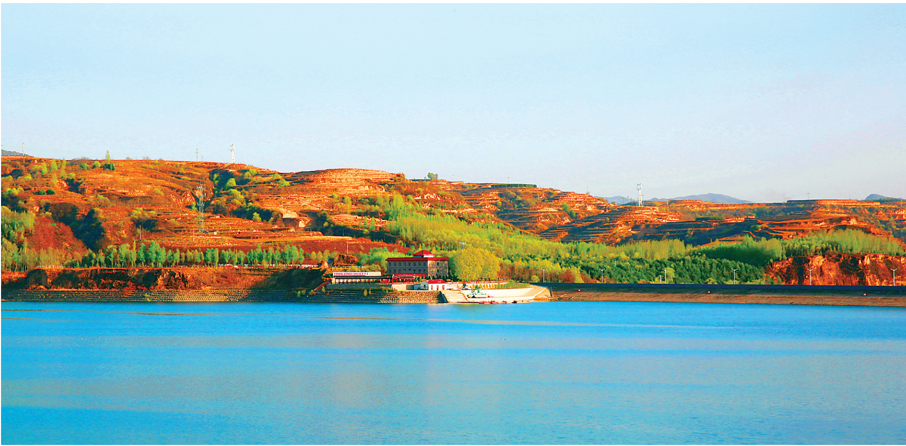
4月23日,傍晚时分的横泉水库景色。横泉水库位于方山县境内的北川河上,控制流域面积800多平方公里,总库容8123万立方米,是一座以城市生活及工业供水、农业灌溉为主,兼顾防洪、发电、旅游等综合利用的多年调节型水利枢纽。横泉水库工程包括水库枢纽工程、灌淤区工程和供水工程三个部分,共占地8765亩。
