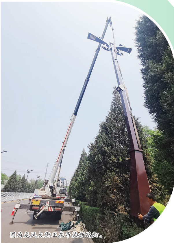
图为工人们正在固定路灯底座,接通电源线。
