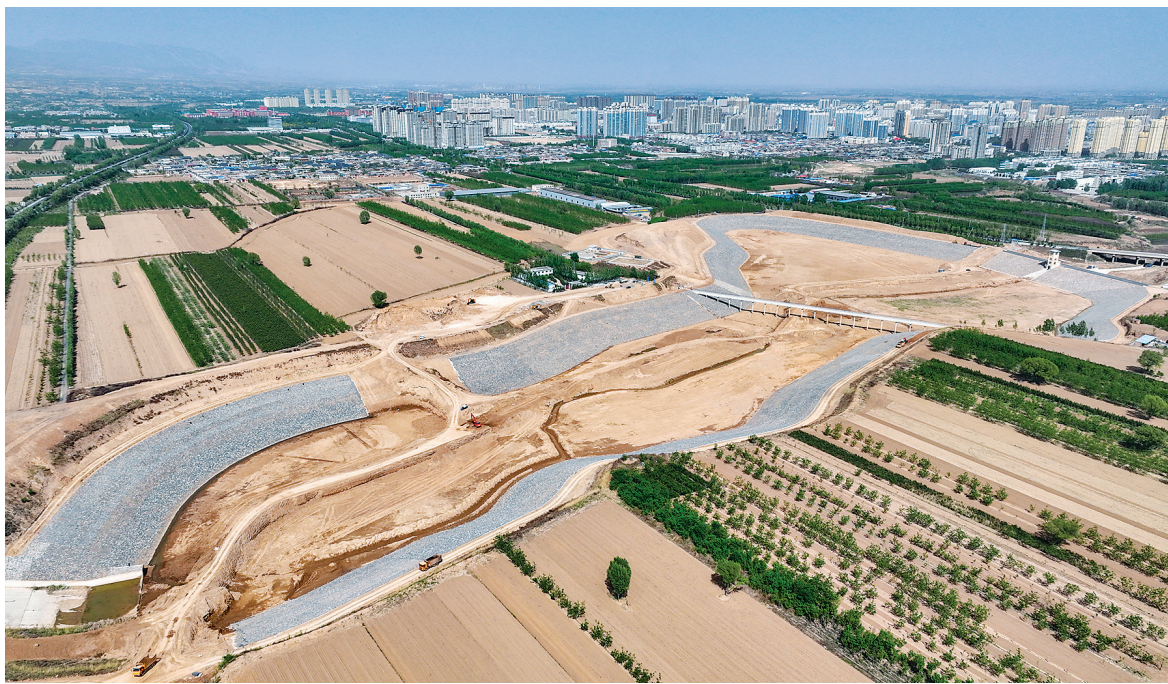
汾阳市花枝水库位于文峪河二级支流董寺河流域的栗家庄镇石家庄村,主要功能以调蓄中部引黄部分供水及提供农业灌溉用水为主,水库总库容为175.6万立方米,设计灌溉面积为2.31万亩,年供水量为116万立方米。目前,花枝水库的工程建设已进入冲刺阶段,各项收尾工作正有序进行。
