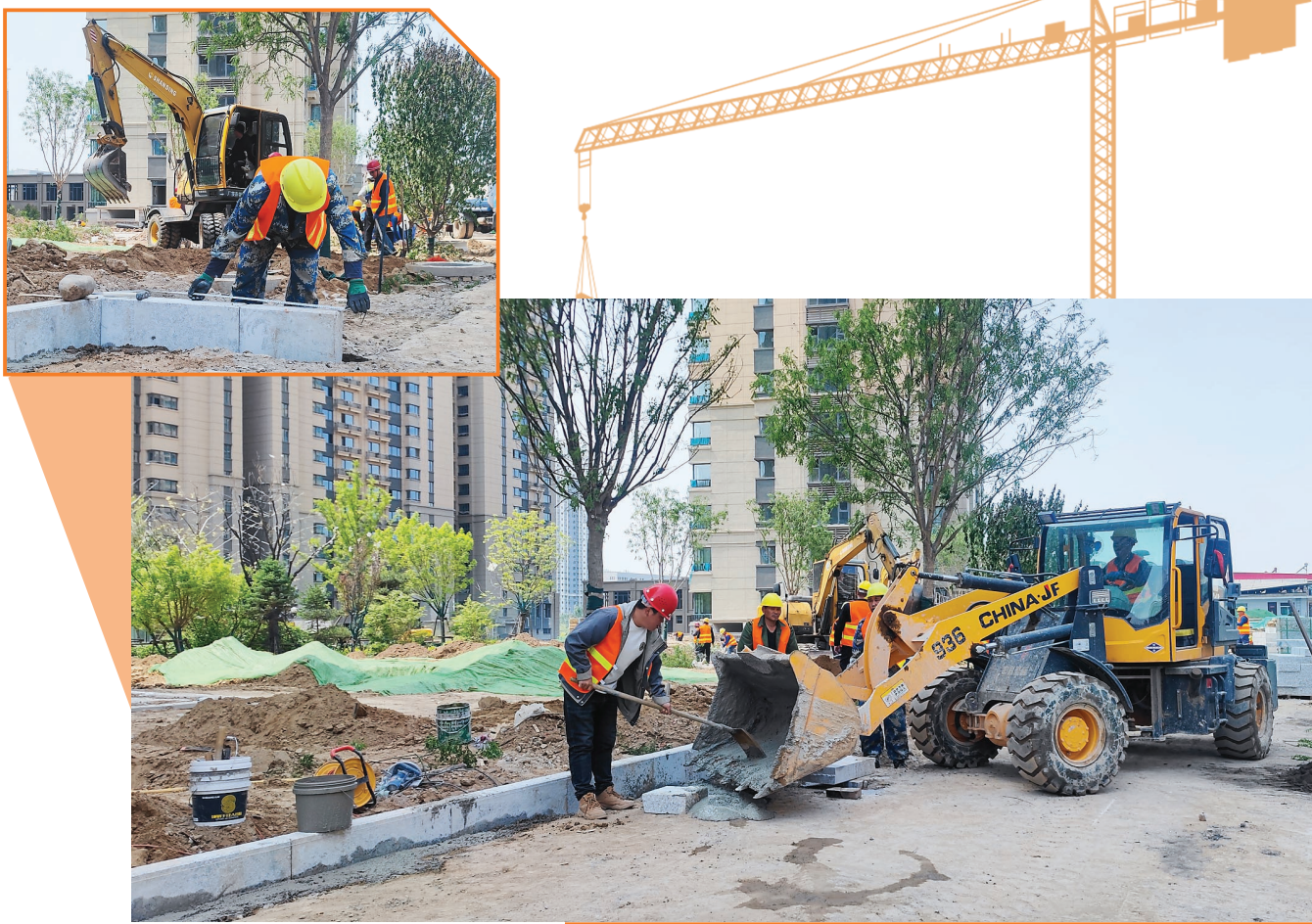
5月6日,在吕梁恒太御府项目现场,工人们正在忙着完成小区道路和绿化带建设,迎接即将到来的“交房季”。自承接吕梁恒太御府保交楼项目以来,吕梁经开区充分发挥建设主体作用,认真贯彻落实中央、省委、市委相关会议精神,强化责任落实,积极筹措资金、保全资产,推动项目建设,确保吕梁恒太御府项目5月底进入交房环节。图为吕梁恒太御府项目现场。
