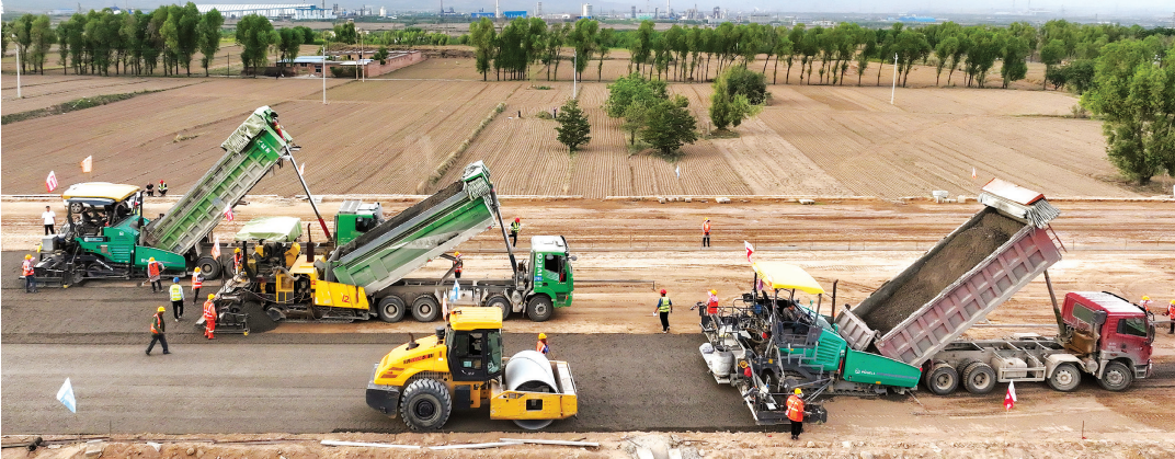
图为汾石高速公路项目施工现场。
