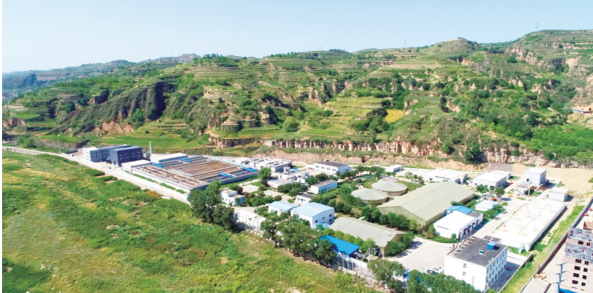
临县污水处理厂建成投用。
