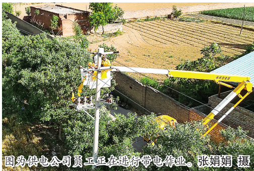
图为供电公司员工在进行带电作业。张娟娟 摄
