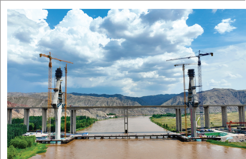
6月26日拍摄的沙坡头黄河公路大桥施工现场(无人机照片)。 宁夏中卫市沙坡头黄河公路大桥全长1539米,为双塔双索面半漂浮体系钢混组合斜拉桥,塔高145米,双向4车道,设计时速80公里,是国道338线中卫至孟家湾段项目的重要控制性工程。 新华社发
