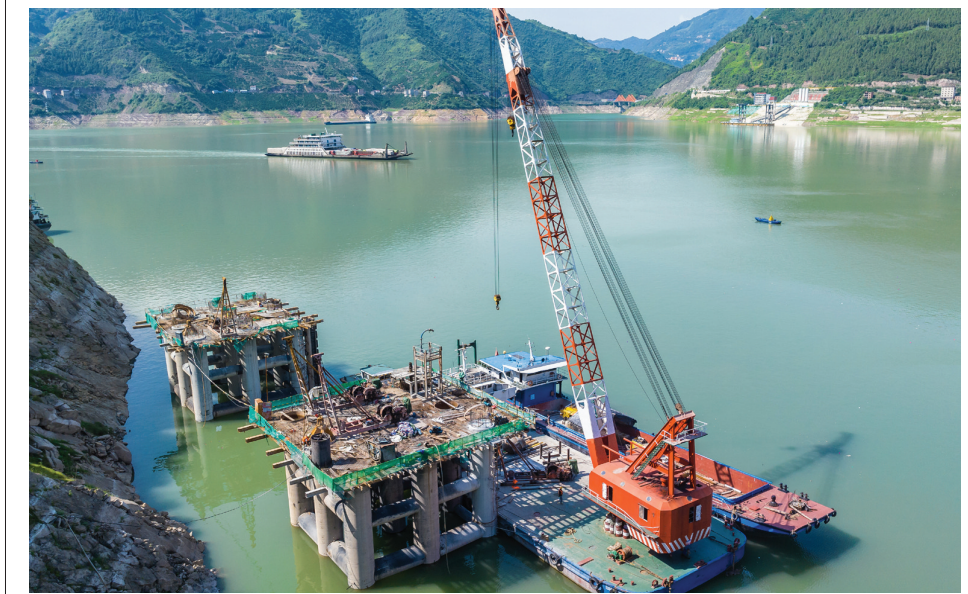
6月29日,船舶从三峡通航船舶归旧州河槽地施工工地前开过(无人机照片)。 该工程位于三峡大坝上游湖北省宜昌市秭归县归州河段右岸,建成后 will 有力缓解三峡船闸上游危化品锚地容量不足问题,提升通航服务水平。
