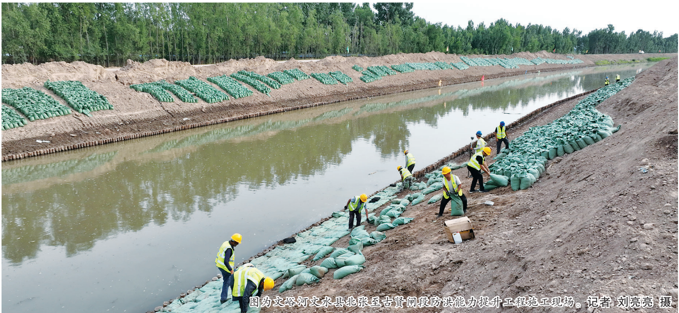
图为文峪河文水县北张至古贤闸段防洪能力提升工程施工现场。记者:刘亮亮摄
