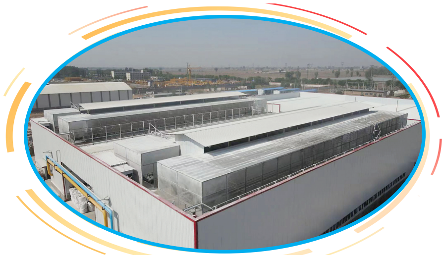
图为文水新名源科技有限公司厂区一角。 温元元 摄
