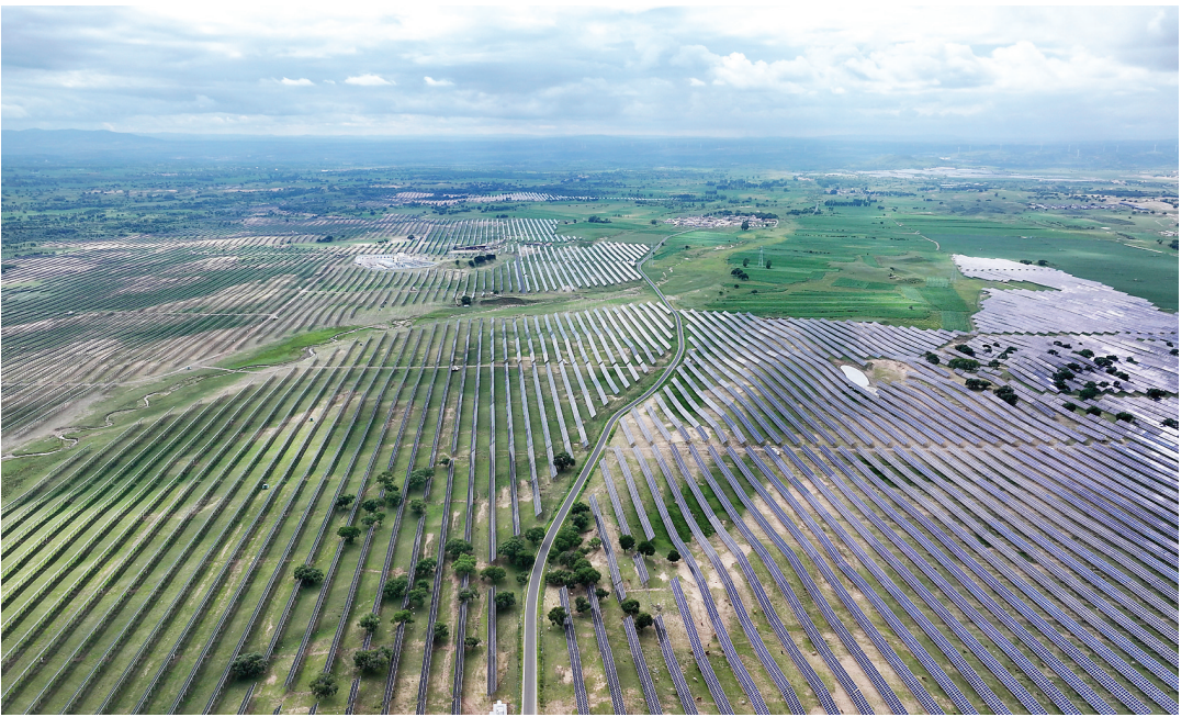
7月25日拍摄的河北省围场满族蒙古族自治县御道口镇附近的一处光伏电站(无人机照片)。
