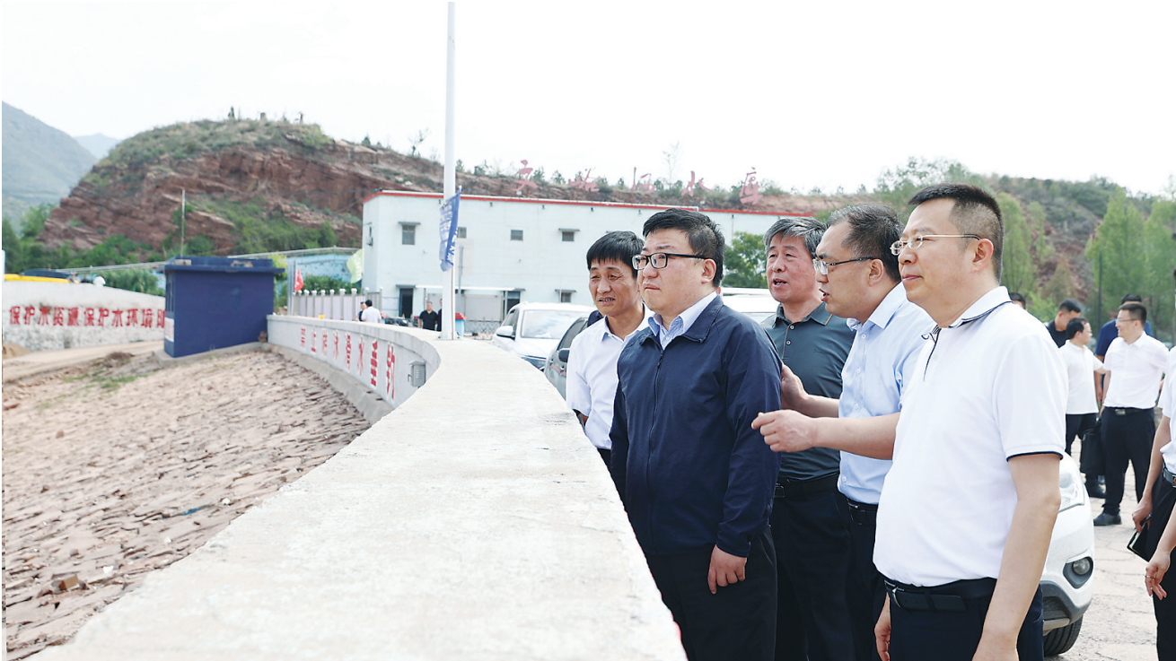
图为省委常委、常务副省长吴伟在文水县文峪河综合整治工程现场检查河道防洪工作。
