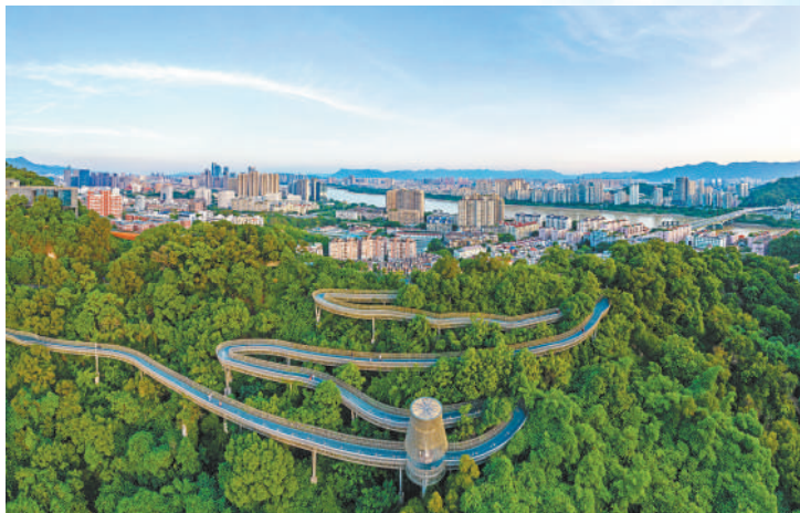
福建福州市在建设“福道”时,采取钢结构高架、镂空桥面栈道、节点大跨度桥梁等创新设计,最大限度保护森林原生态。 林双伟 摄(人民视觉)
