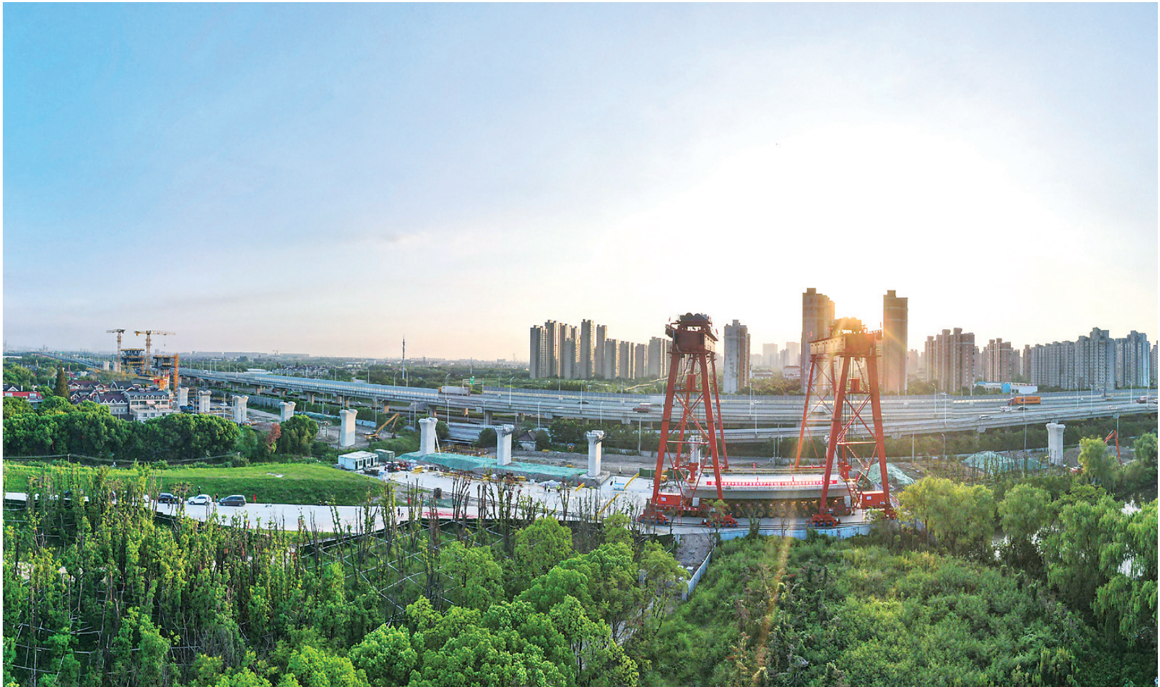
空中俯瞰沪渝蓉高铁上海段首榀箱梁架设施工现场（8月26日摄，无人机照片）。
