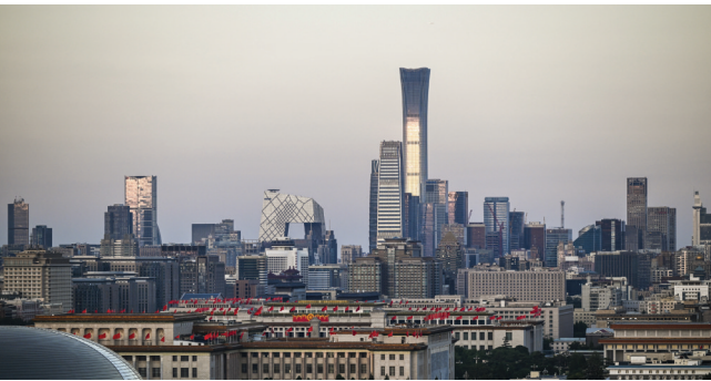
9月2日黄昏，北京CBD的高层建筑反射出夕阳金色的光辉。 新华社记者 王建华 摄
