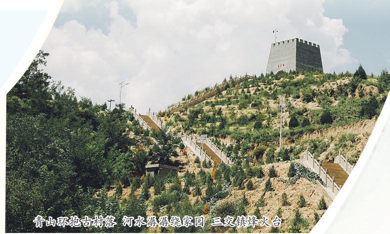
青山环绕古村落 河水潺潺绕家园 三交镇烽火台
