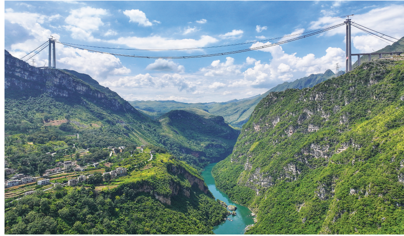
这是建设中的花江峡谷大桥(无人机照片,9月3日摄)。
