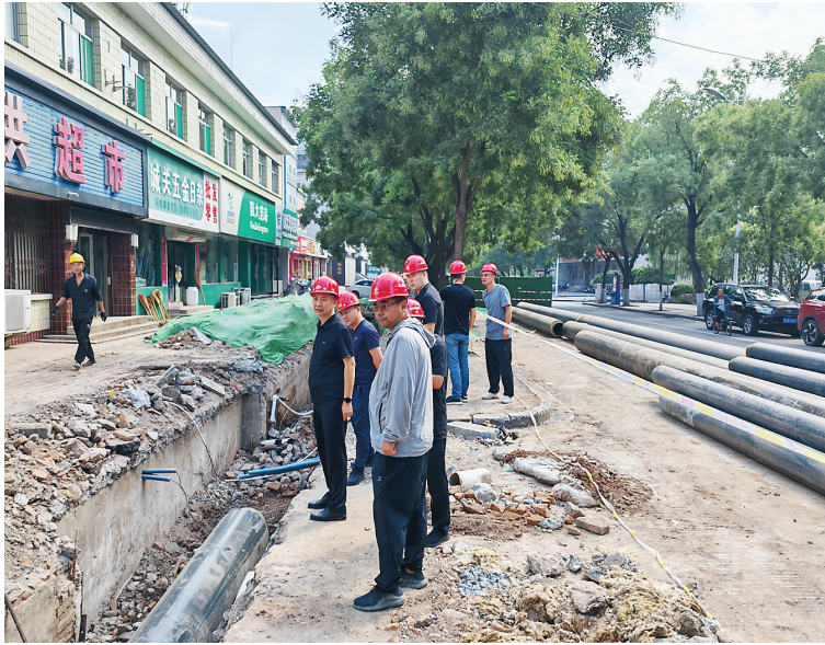
图为交城县老旧热力管道更新改造施工现场。 冯海砚 摄
