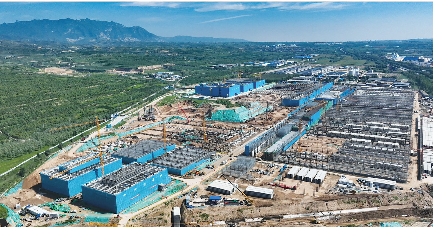
位于汾阳杏花村经济技术开发区的汾酒2030技改原酒产储能扩建项目(一期),是杏花村经济技术开发区重点项目之一,对提升原酒产能、延伸酿造产业链、壮大杏花村汾酒特色专业镇,以及助力吕梁打造500亿级白酒产业发展集群,将起到重要的引领带动和关键支撑作用。目前,项目办公区、生活区、部分陶坛库等9个单体主体已封顶,白酒库、酿酒车间等单体主体正在施工中。
