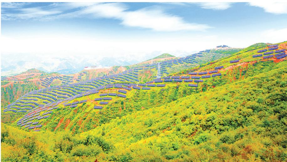
方山国网能100兆瓦农光互补光伏复合项目利用光伏发电与农业林业相结合的复合模式,年平均发电量达15714.93万千瓦时,每年减少碳排放约15万吨,推动了当地能源绿色低碳转型。
