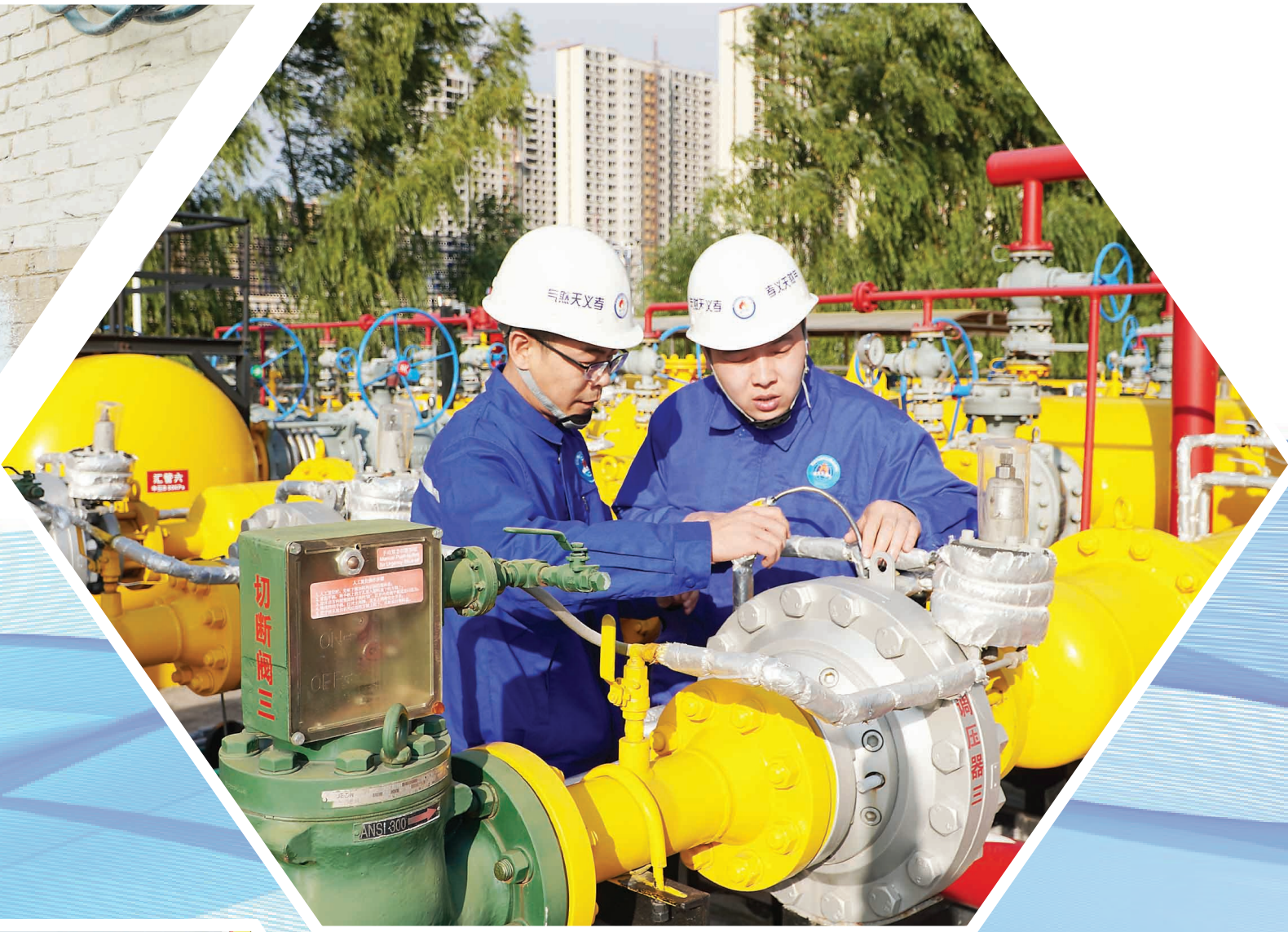
检查维护冬供设备
