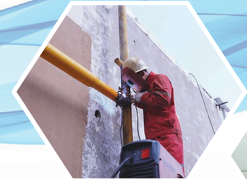
拆除封堵管道
