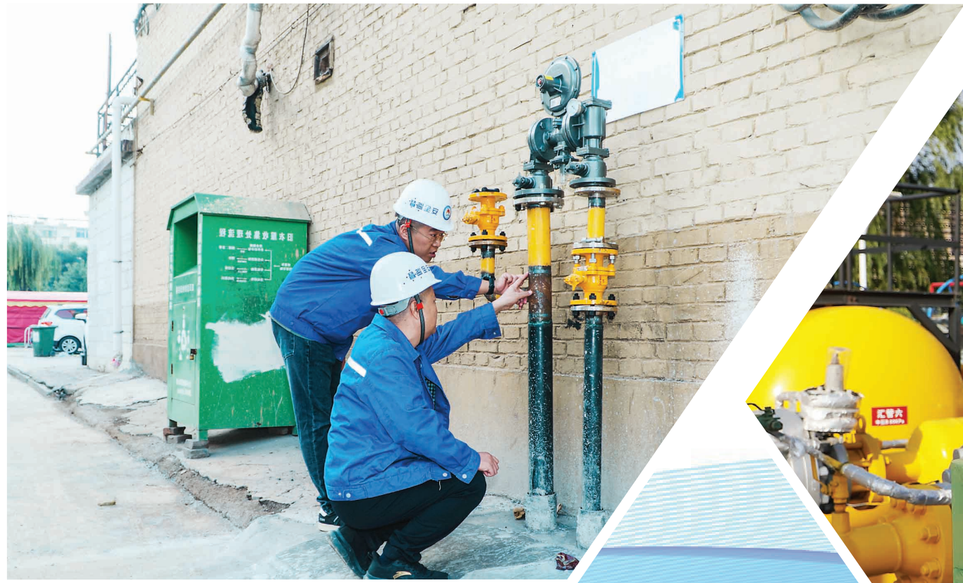
检查小区主管网是否存在泄漏
