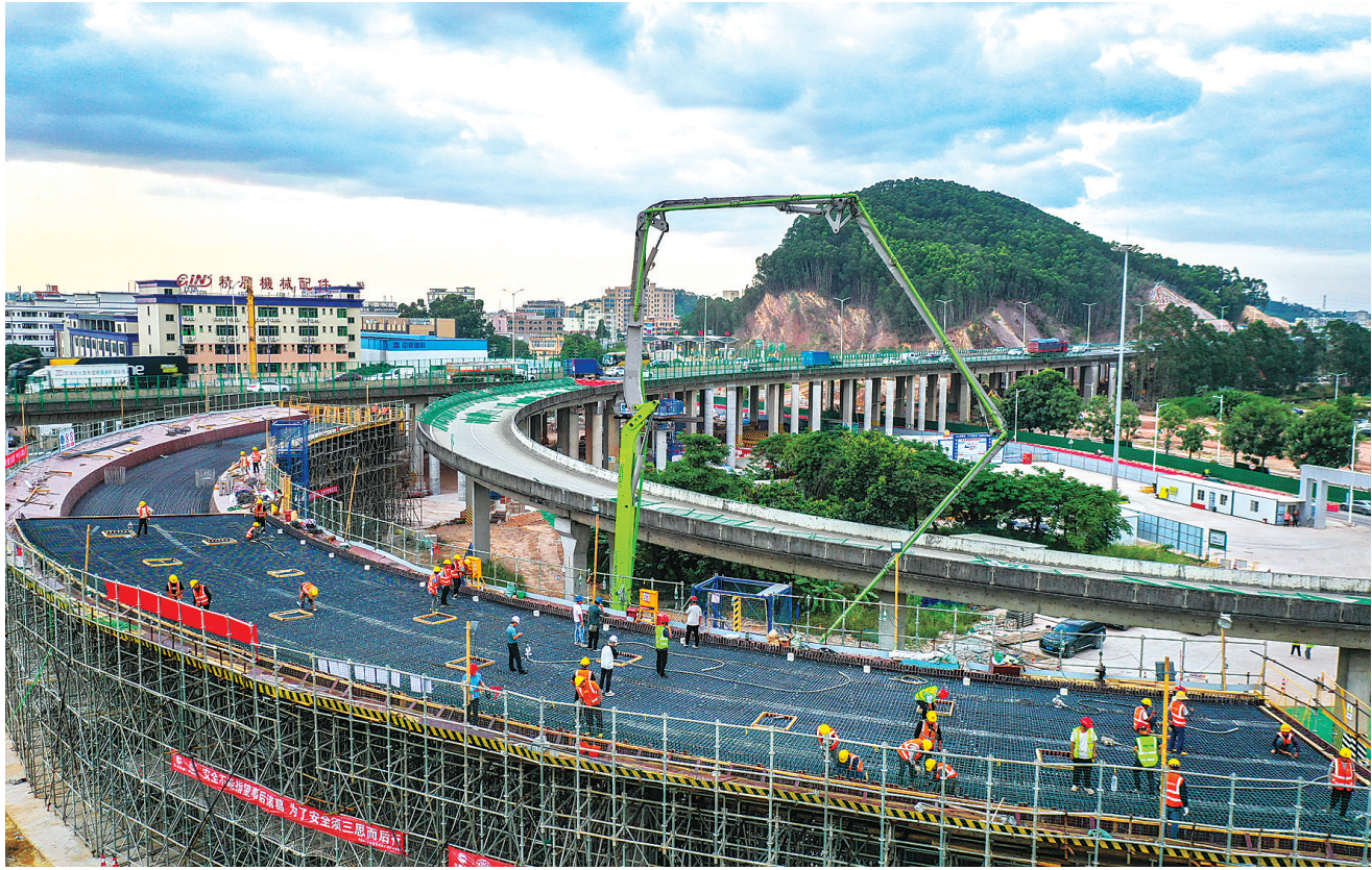
建设者在东莞路桥常虎高速改扩建项目莞樟互通浇筑筑全线首块现浇梁(无人机照片,10月22日摄)。
