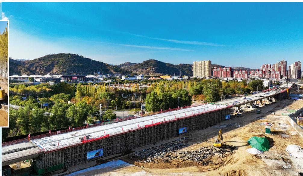
经过中建三局建设者们近两年的奋战,吕梁市新安大道项目全线跨线桥主体结构已贯通,路面东半幅完成施工进度的60%。桥梁桩基施工累计完成482根,墩柱累计完成80组,箱梁浇筑累计完成27联。七座主线桥梁中纬三十路、纬二十六路及纬十三路3座桥梁主体结构已顺利贯通。由原G209临安路段升级改造而来的吕梁市新安大道项目,南起离石区文丰路北,北至方山县军纬一路,建设工程全长18.4公里,建设内容包括道路、桥涵、排水、供热、照明及绿化等。项目完工后,主干道与东西向道路立体交叉,仅需15分钟即可实现快速通行。
