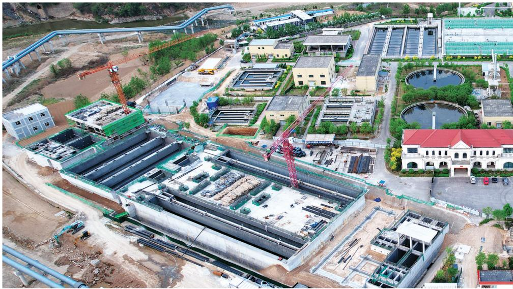
吕梁市第二污水处理厂三期建设项目日处理3.5万m<sup>3</sup>,投资概算16412.14万元,处理工艺为五段式改良AAO活性污泥法。主要建设内容包括101粗格栅及沉砂池、102预处理车间、103生物池及污泥泵房、104沉淀池、105中途提升泵房及混合反应沉淀池、106纤维转盘滤池及紫外消毒渠、107巴氏计量槽、201鼓风机房、301储泥池、302污泥处理车间、401分支配电间、除臭设备及配套管路、总管及管线、道路、绿化及围墙修复等。项目建成投入使用后,将有效提升我市污水处理能力,改善城乡水环境和水体环境,实现区域经济社会的可持续发展。目前,该项目正在倒排工期,确保主体工程如期完工。
