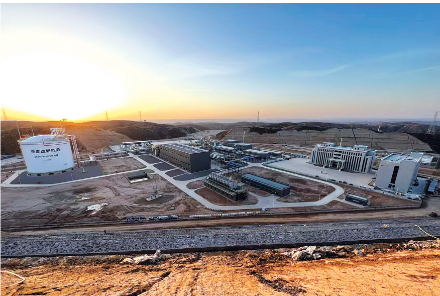
图为山西泽丰达新能源有限公司兴县天然气(煤层气)液化提氢制氢项目现场。 阮兴时 摄
