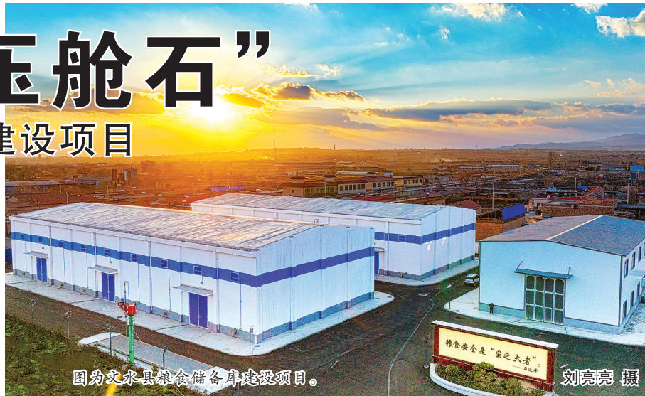
图为文水县粮食储备库建设项目。
