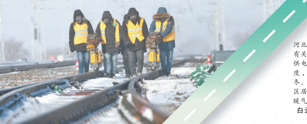
▼为保障冬季电煤运输,铁路部门全力加强运力保障。图为中国铁路呼和浩特局集团有限公司锡林浩特综合维修段工作人员利用超声波钢轨探伤仪检查钢轨状态,确保恶劣天气下煤炭铁路运输安全畅通。 张彬 杨庆臣 摄影报道
