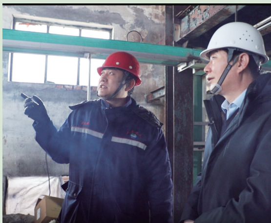
蔺拴全（右一）查看施工进度
