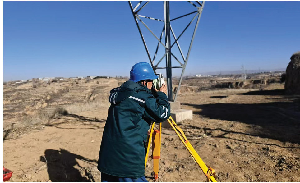
1月3日,国网吕梁供电公司输电带电作业班人员在柳罗一二线20#-25#采空区对线路弧垂、杆塔倾斜情况进行测量记录,并及时更新设备台账。
