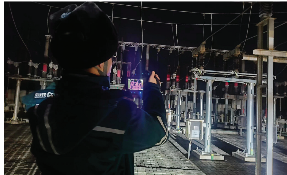
1月10日,吕梁公司二次运检中心组织电气试验专业人员对岚县辖区110千伏及以上变电站开展红外特巡。
