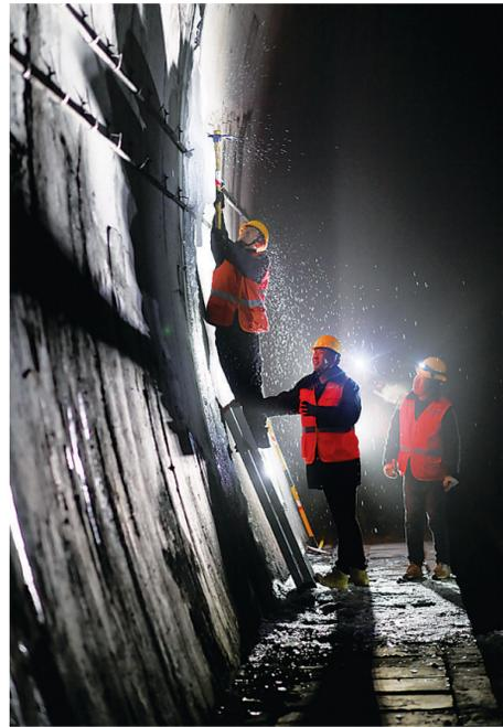
中国铁路太原局集团有限公司太原南工务段吕梁山隧道打冰工在隧道里除冰。
