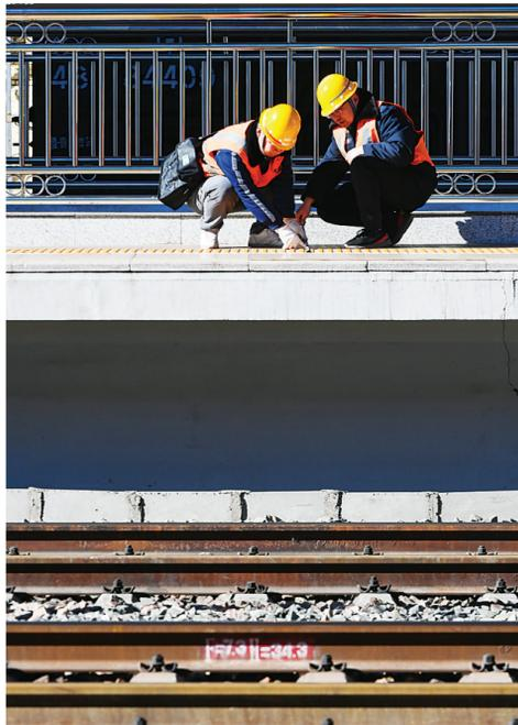
吕梁房建车间工人刘春喜(左)、闫杰(右)对吕梁站站台面砖冻胀拱起部位进行测量。
