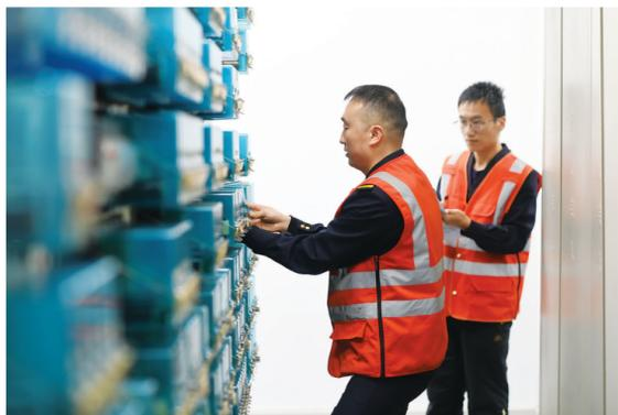
中国铁路太原局集团有限公司太原电务段吕梁车间景龙宾(左)、梁宁(右)正在对太中线吕梁站道岔继电器按维护周期进行更换。
