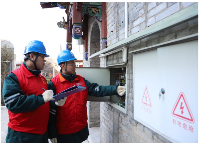
2月10日,吕梁孝义市供电公司组织党员服务队和青年突击队前往博物馆,开展用电设备安全隐患排查工作
