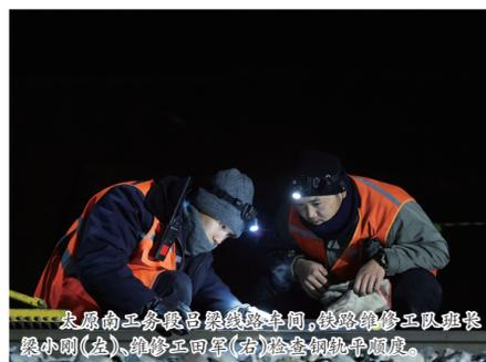
太原南工务段吕梁铁路车间, 铁路维修工队班长梁小刚(左)、维修工田军(右)检查钢轨平顺度。
