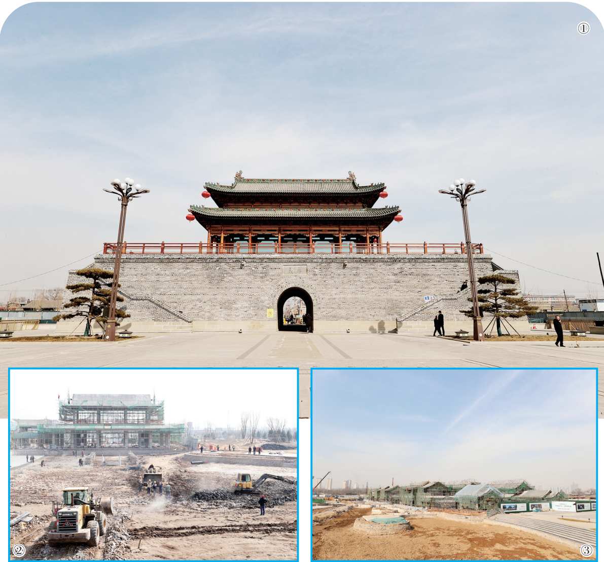
随着城市化进程的加快，旧城区的改造升级已成为推动城市发展的重要一环，为了提升城市形象，改善市民生活居住环境，近年来，孝义市采取“政府+企业+集体经济组织+股民”的方式，加大对旧城区开发、改造、保护投入力度。中阳楼街道旧城片区改造项目主要包括南稍门、护城河、市政基础设施、建筑风貌、老城区文旅设施、安置房等提升建设工程。项目完成后将有效助力城市提档升级，使市民幸福感、获得感倍增。 图①为建设好的孝义门。 图②③为工人师傅正在热火朝天的施工当中。
