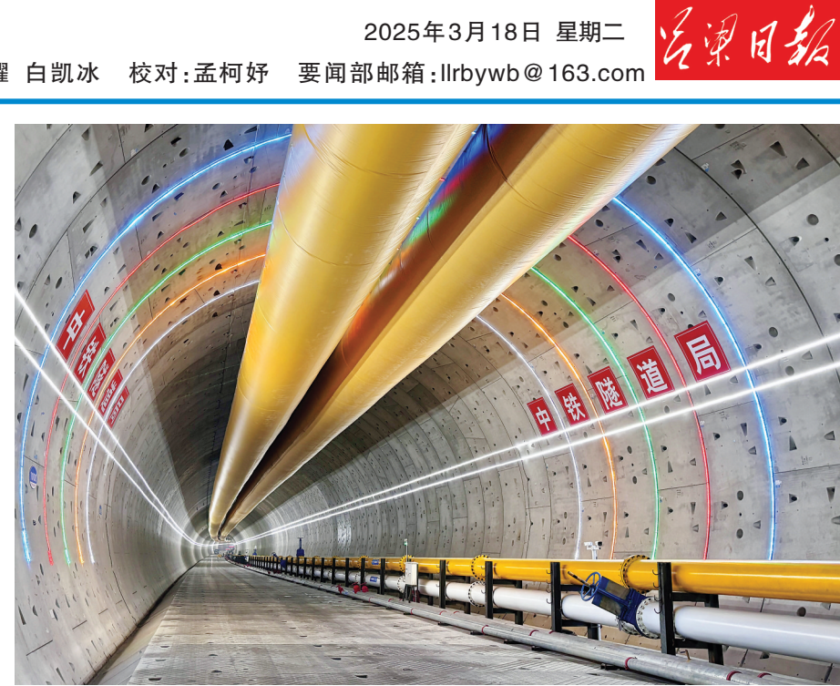
这是沪渝蓉高铁崇太长江隧道成型隧道内景(3月16日摄)。当日，由沪杭客专公司建设、中铁隧道局施工的沪渝蓉高铁崇太长江隧道掘进突破 5000 米，距离江心仅剩 660 米。崇太长江隧道采用“领航号”盾构机掘进施工，盾构机刀盘直径 15.4 米，搭载智能掘进、智能拼装、超前地质预报等创新技术，以“有人值守、无人操作”的方式，由上海崇明向江苏太仓独头掘进，是目前世界最大直径高铁盾构机。
