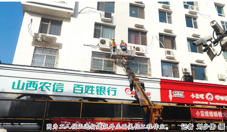
图为工人们正在进行建筑外立面美化工程作业。 记者 刘少伟 摄
