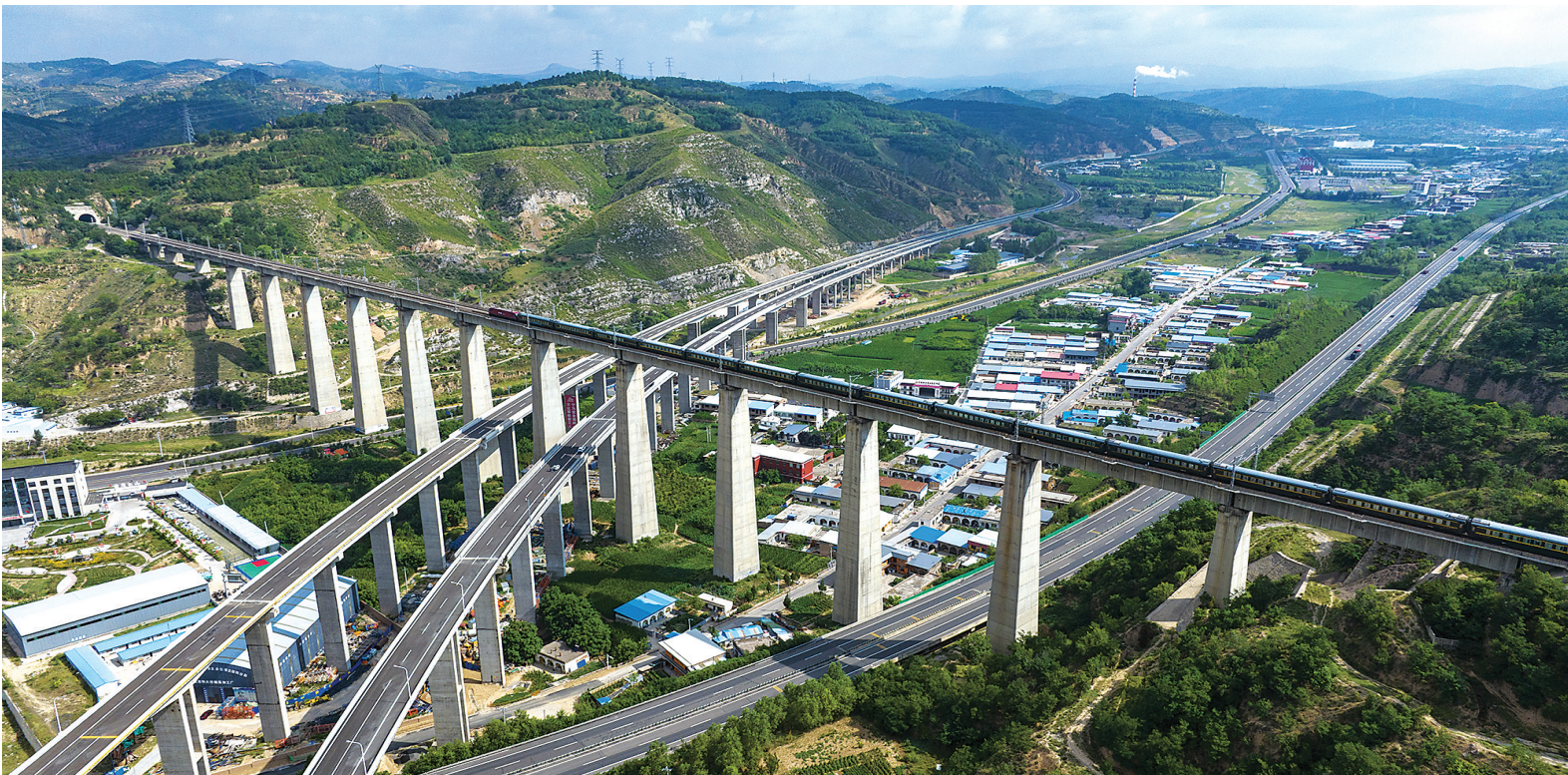
图为无人机拍摄的吕梁市区立体交通新格局。
