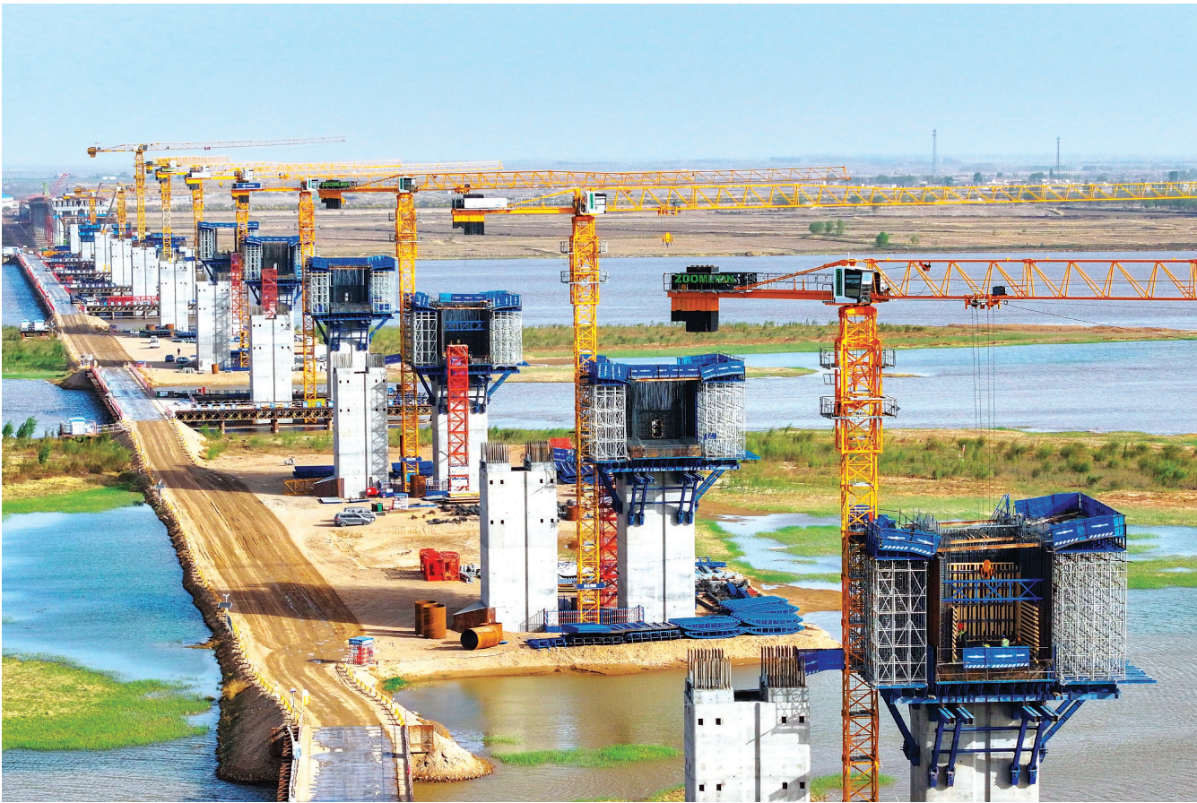
5月8日拍摄的国道110线磴口黄河大桥上部箱梁悬浇施工现场。 当日,由内蒙古路桥集团和中交二公局承建的国道110线磴口黄河大桥工程全面进入预制梁架设和上部箱梁悬浇作业阶段,标志着整个大桥进入上部结构施工阶段。该工程横跨内蒙古自治区巴彦淖尔市磴口县与鄂尔多斯市杭锦旗黄河两岸,全长3098米,是国道110线北京至宁夏青铜峡公路的控制性工程。 新华社发(王正 摄)
