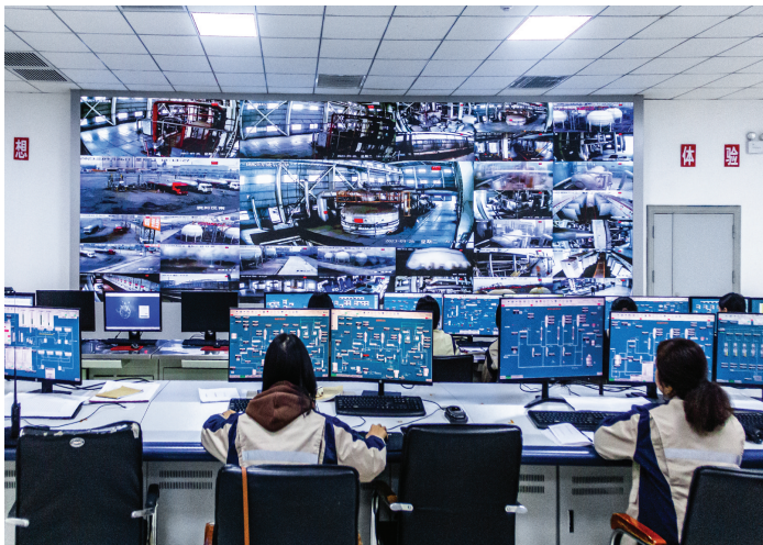
东锦肥业中央控制室
