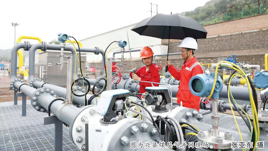
图为兴县煤层气并网现场。张亚东 摄
