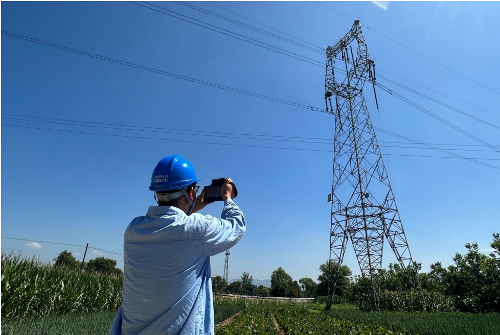
7月15日,吕梁供电公司输电运检中心运维人员在所辖跨高速线路区段开展红外测温。
