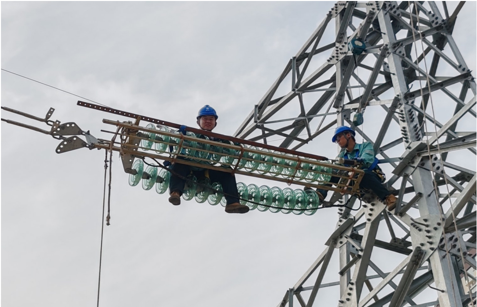
7月10日,吕梁供电公司输电运检中心开展第三阶段全业务核心班组建设实操技能培训。
