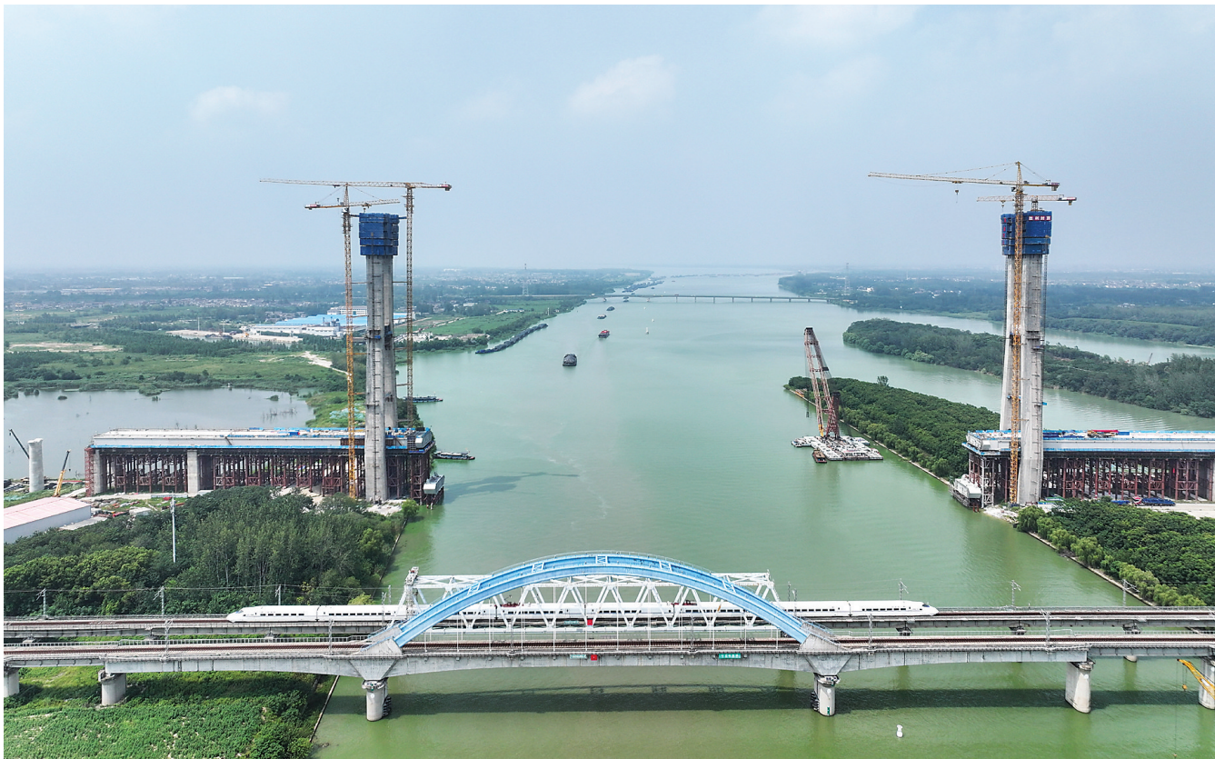
这是8月5日拍摄的沪渝蓉高铁跨京杭运河斜拉桥建设现场(无人机照片)。当日,由中国铁建大桥局承建的沪渝蓉高铁跨京杭运河斜拉桥主塔顺利封顶。至此,大桥核心支撑结构施工圆满收官,项目全面转入钢梁及斜拉索安装新阶段。该桥位于江苏扬州境内,是沪渝蓉高铁全线关键控制性工程,桥长564.3米,主跨300米。沪渝蓉高铁是国家“八纵八横”高铁骨干通道之一,线路总长约2100公里,设计时速350公里。
